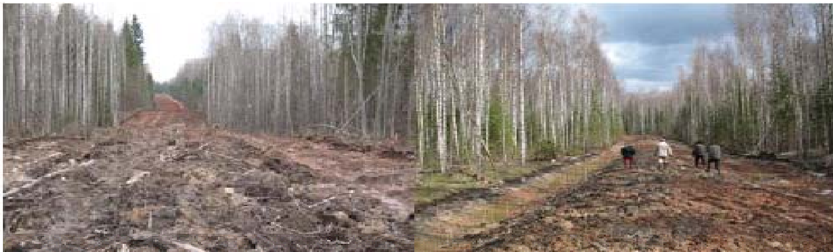
Kuvat 4 ja 5. Rakentamisolosuhteista Tihvinästä. (Greis, I)
